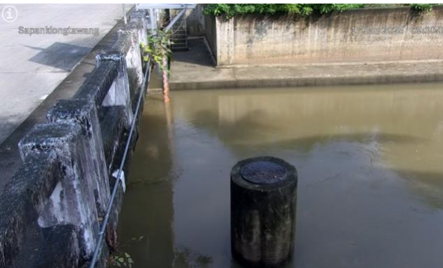
TC191912 : สะพานคลองท่าวัง เทศบาลนครนครศรีธรรมราช อ.เมือง จ.นครศรีธรรมราช
